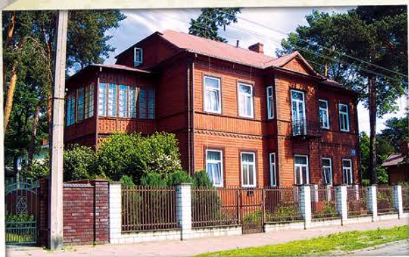
Budynek w stylu świdermajer, przy ul. Kościelnej w Otwocku. Swidermajer style facility at Kościelna Street in Otwock.
