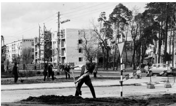
Budowa ul. Hożej
