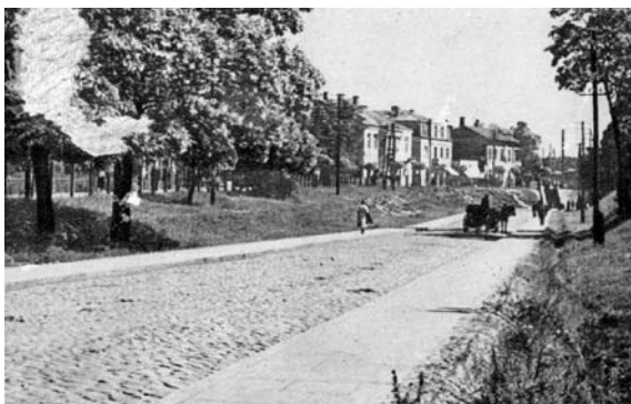
Zjazd pod wiadukt kolejowy od strony ul. Warszawskiej
