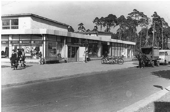
Pawilony handlowe PPHW na Placu Niepodległości
